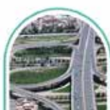
مسیرهای دسترسی پل ۹ دی
