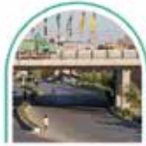
تقاطع غیرهمسطح سلام
