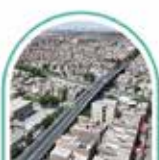
پل روگذر میثم
